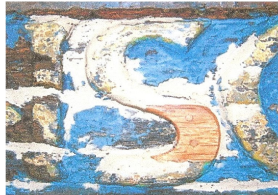
Schnitzergänzungen aus Eichenholz und durch Kittung (Foto Erdmann & Ahrends)
